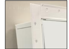
Drywall Bead Flange
